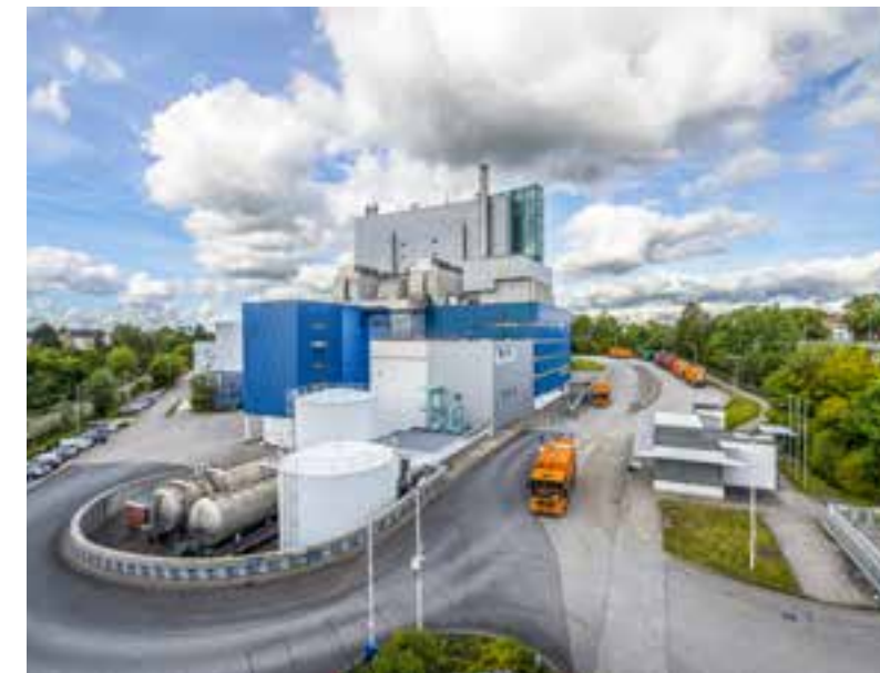
Abfallentsorgung, Strom- und Fernwärmeerzeugung: die MVK
