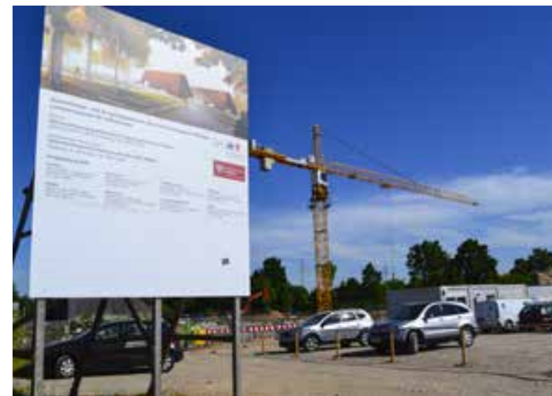
Der Bau des neuen Ausstellungs- und Eingangsgebäudes ist in vollem Gange Fotos: Sellhoff
