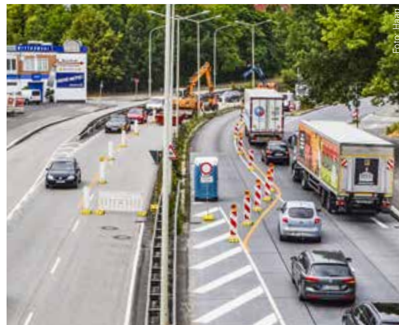
Am 23. Juli haben die Bauarbeiten auf dem Theodor-Heuss-Ring begonnen
