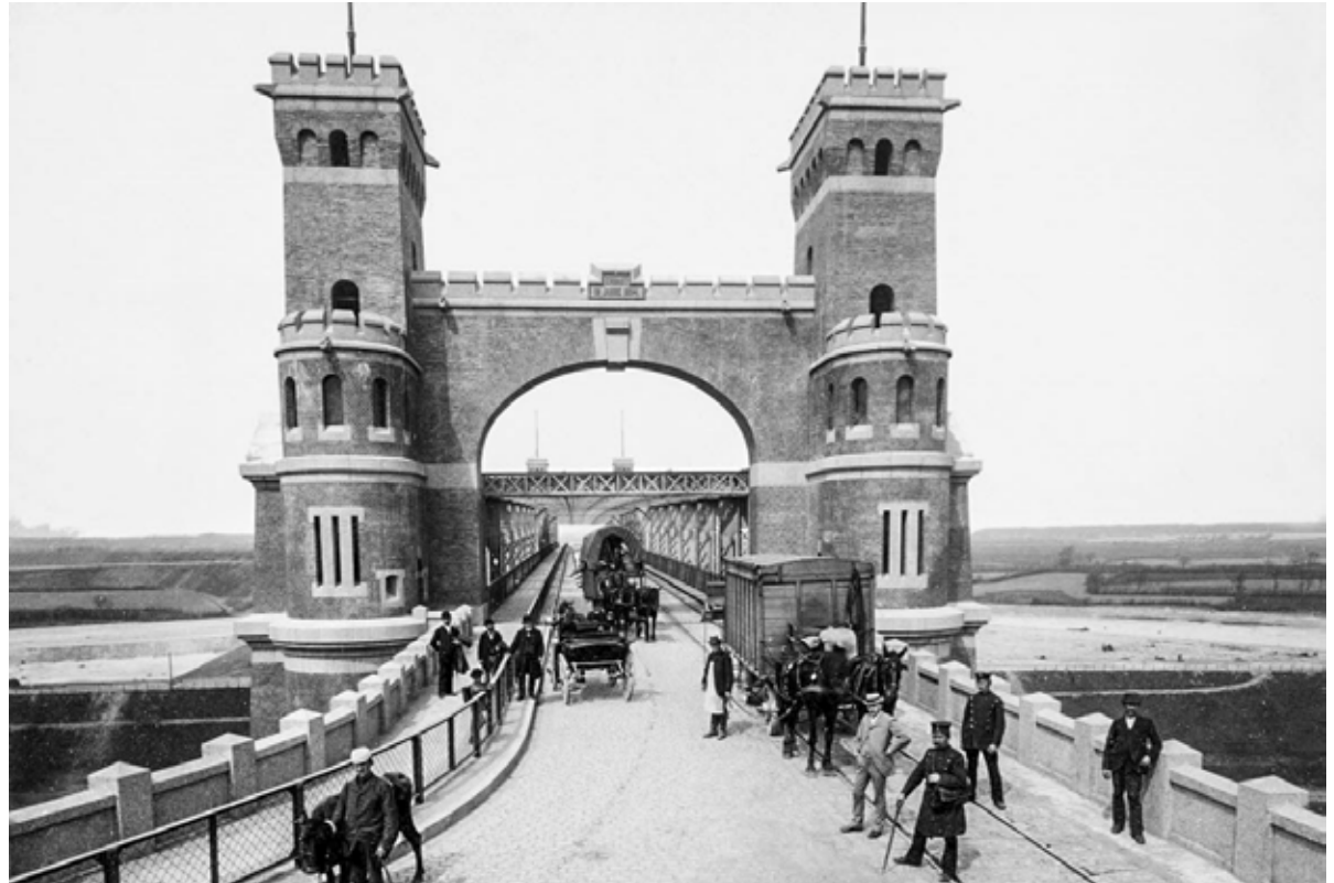
Levensauer Hochbrücke: Architektonisch von Hermann Muthesius gestaltet
