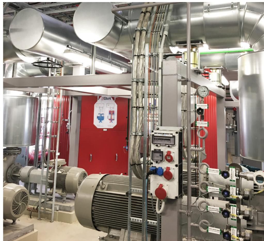
Der Elektrodenkessel erweitert die Erzeugungsmöglichkeiten für die Fernwärme. Vergleichbar mit einem „Durchlauferhitzer“ erzeugt die Anlage heißes Wasser aus Strom
