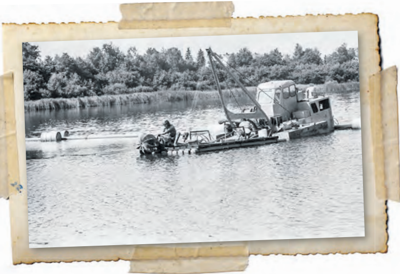
1975: Der Vordere Russee wird entschlammt. Vor der Einmündung der Speckenbeker Au in den Russee wurde ein Bagger eingesetzt, der innerhalb eines Jahres 100.000 Kubikmeter Schlamm aus dem See entfernen soll.
