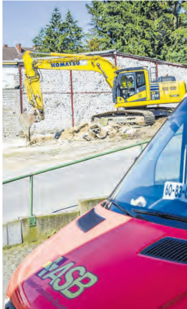
Kaum ein Rest ist mehr zu sehen: Der Bagger ebnet die Oberfläche nach dem Abriss des alten Materiallagers.
