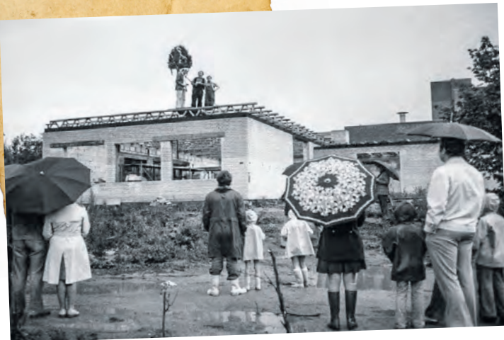
1974: Richtfest beim Neubau des TSV-Vereinsheims an der Rendsburger Landstraße 251.
