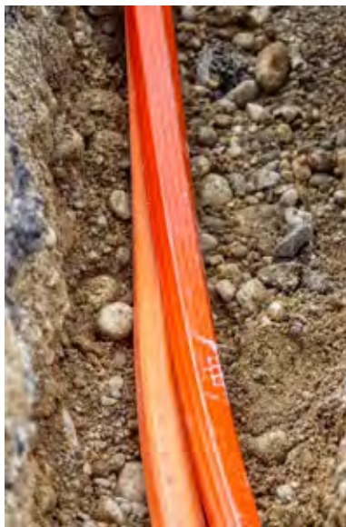
Nein, das ist nicht schon das eigentliche Kabel: Zunächst werden Leerrohre verlegt.
