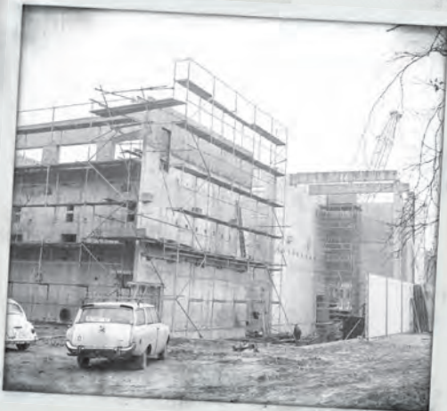
1972: Ausbau des größten Kieler Wasserwerks an der Hamburger Chaussee.
