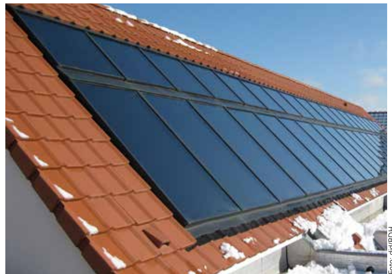
Die Kraft der Sonnenwärme kann mittels Solarthermie für die nachhaltige Wärmeversorgung eines kompletten Einfamilienhauses sorgen.
