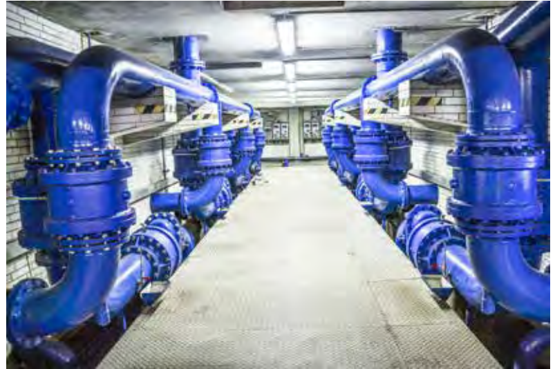
Die Exkursion bietet ungewöhnliche Einblicke in das Wasserwerk.
