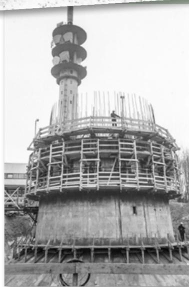
Dezember 1973: Betonieren des Fundaments. Neun Transportfahrzeuge bringen innerhalb von 24 Stunden rund 1.400 Kubikmeter Beton an die Baustelle, in der außerdem 270 Tonnen Stahl verarbeitet werden.
