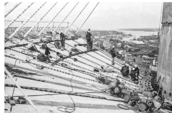
Juli 1974: Bauarbeiten in luftiger Höhe. Die 48 Segmente der Kegelschale für die Betriebskanzel werden mit 10.000 Schweißungen verbunden. Von oben bietet sich ein guter Blick auf die Kieler Förde (im Hintergrund).
