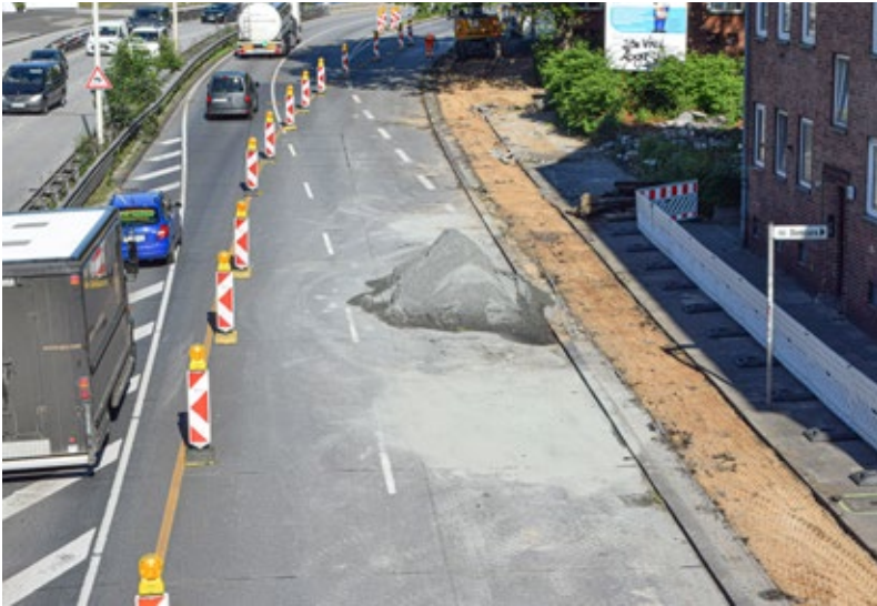
Der Geh- und Radweg am Theodor-Heuss-Ring erhält einen neuen Belag. Dieser soll Schadstoffe aus der Luft binden.
