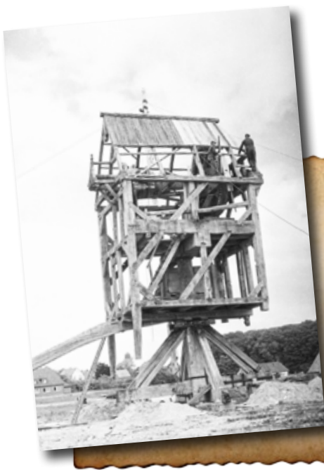
1965: Das Holzständerwerk der Bockwindmühle aus Algermissen (1766).
