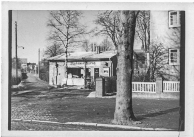
1961: Die Birkenklause (später Blockhütte) in der Gärtnerstraße. Links der Fußweg am Bahndamm zur Saarbrückenstraße
