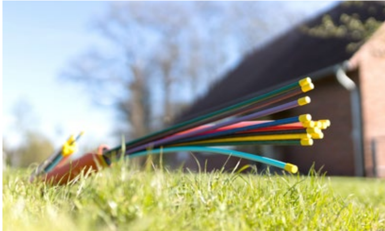
TNG verzichtet auf dem gesamten Weg bis zur Hauseinführung auf die störanfälligen Kupferkabel und verlegt zu 100 % Glasfaserkabel. Foto: TNG
