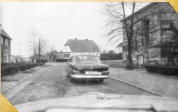
An der Ecke Holunderbuch / Pappelweg befindet sich der Otto-Streibel-Bunker, ein Überbleibsel aus dem Zweiten Weltkrieg. Der Bunker wurde erst vor wenigen Jahren zu Wohnzwecken ausgebaut.
