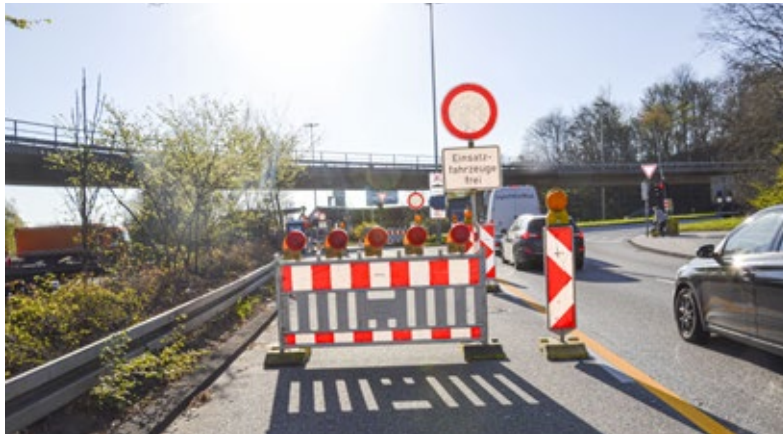
Der Theodor-Heuss-Ring ist diesmal nicht gesperrt, dafür aber der sogenannte „Überflieger“ (im Hintergrund) und die Kreuzung darunter. Foto: Carsten Frahm
