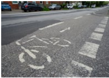
Der einseitige Fahrradweg am Wulfsbrook soll erneuert und dabei auch verbreitert werden.
