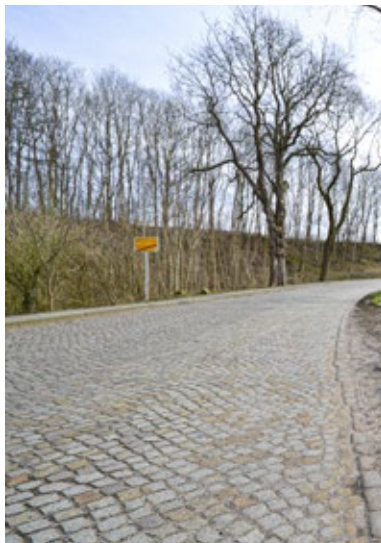
In Rothenhahn ist nach der Begradigung noch ein Abschnitt mit der alten Pflasterung erhalten.
