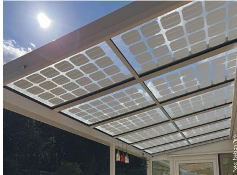
Die lichtdurchlässigen PV-Module sind in die Glaseindeckung integriert.
