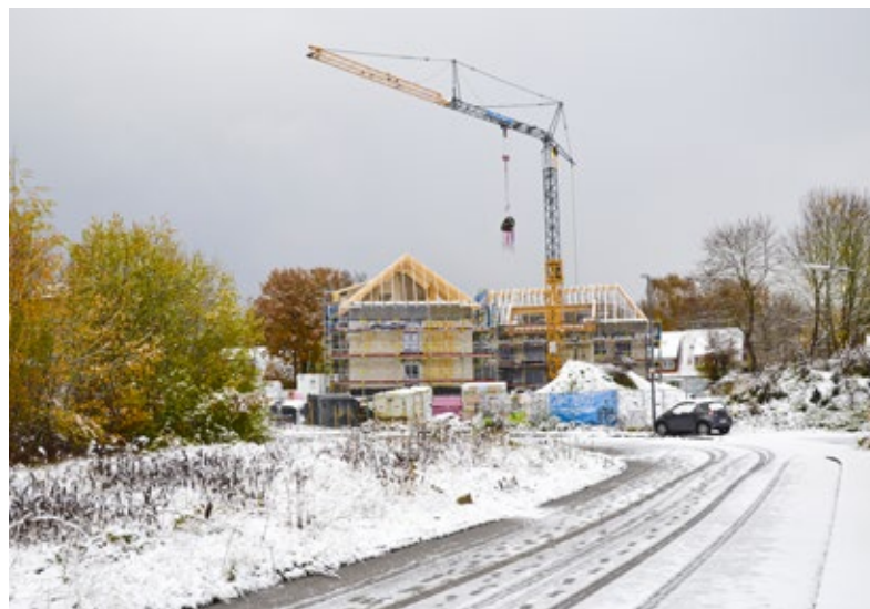
Für die Erschließung der Neubauten wird die Hofteichstraße ausgebaut. Auf der Grünfläche links soll ein neuer Spielplatz geschaffen werden. Fotos: Carsten Frahm
