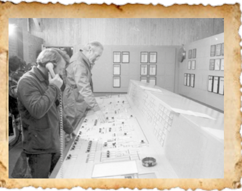
November 1975: Vom Leitstand aus wird die gesamte Anlage geregelt und überwacht.
