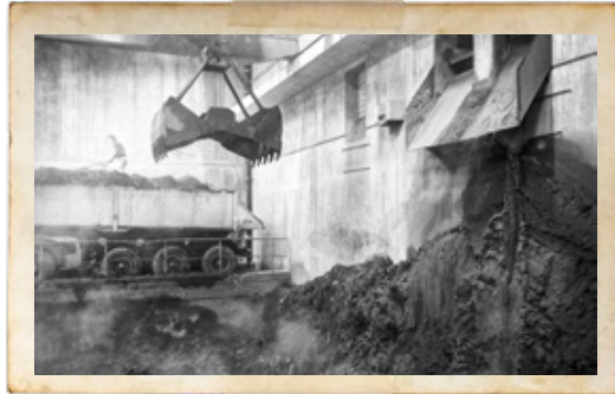
November 1975: Verbrennungsrückstände (Schlacke) werden als Wegebbaumaterial mit Lastwagen abtransportiert.
