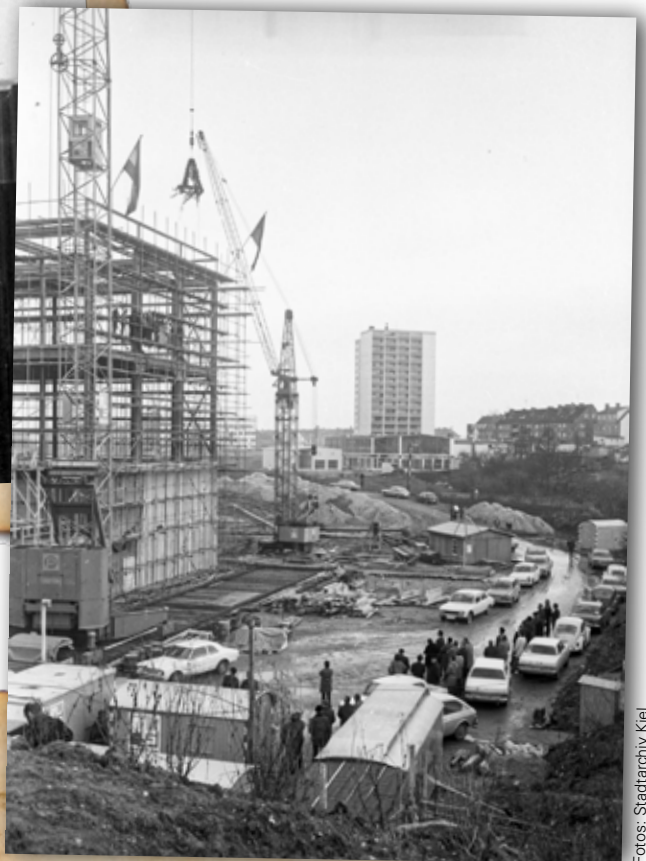
Februar 1973: Richtfest am Rohbau mit Richtkranz am Baukran. Im Hintergrund das Hochhaus an der Rendsburger Landstraße.
