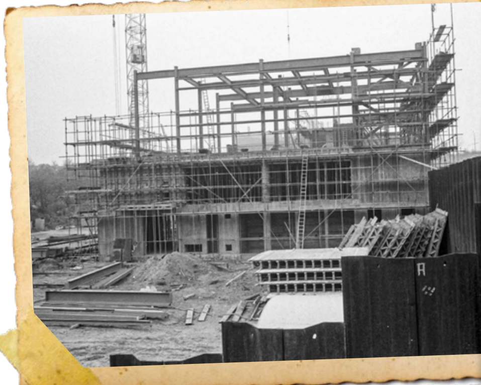
November 1972: Beginn der Bautätigkeiten für die Müllverbrennungsanlage im Heizwerk Süd am Theodor-Heuss-Ring 30. Der Rohbau steht.
