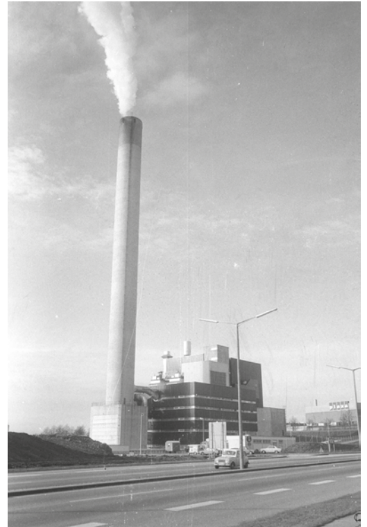
November 1975: Europas modernstes Müllheizkraftwerk versorgt etwa 2.000 Wohnungen mit Wärme und Warmwasser. Die Anlage ist seit Juli 1975 Tag und Nacht in Betrieb und erfüllt alle Anforderungen des Umweltschutzes.
