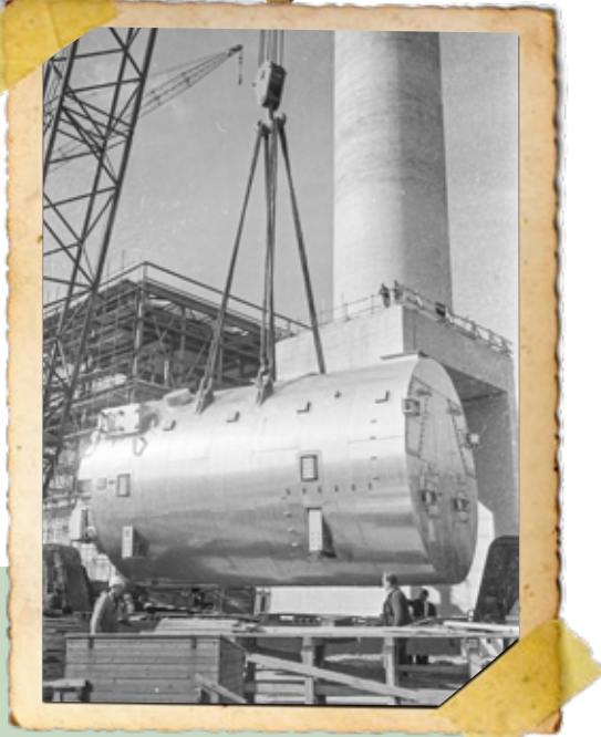
Mai 1973: Die Heizkessel kommen. Jeder der beiden Kessel wiegt 70 Tonnen und muss mit einem speziellen Autokran bewegt werden.
