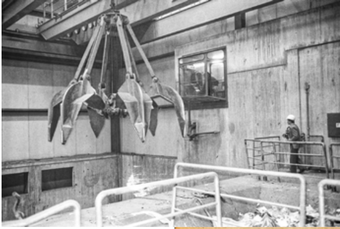
November 1975: Greiferkran über dem Müllbunker.
