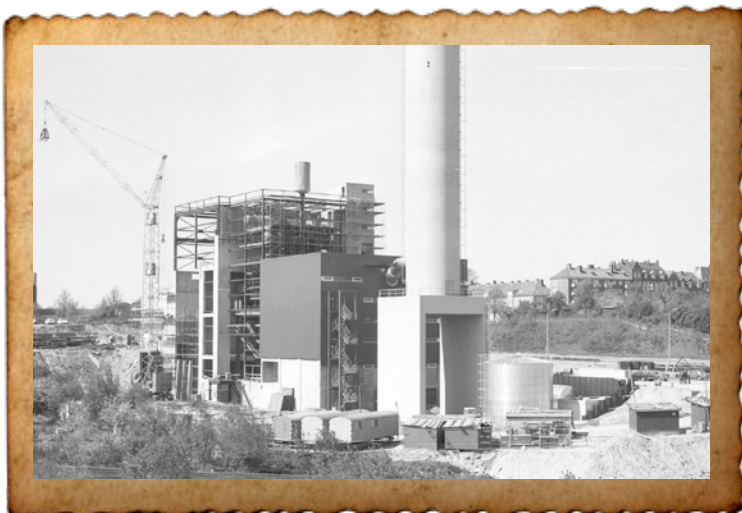
Mai 1974: Erneutes Richtfest an dem nun schon deutlich fortgeschrittenen Neubau.
