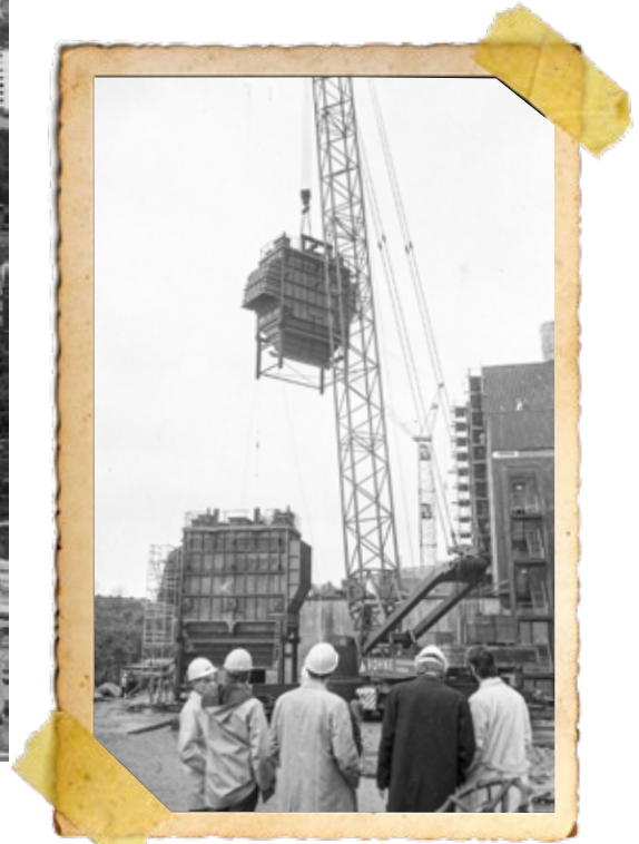
Oktober 1974 Einbau von zwei je 60 Tonnen schweren Filtern, die den Staub aus den Abgasen herausfiltern. Die Kieler Müllverbrennungsanlage ist die erste derartige Anlage in Europa, die über eine Rauchgaswaschanlage verfügt
