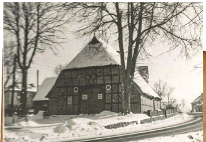
Das Nagelsche Haus, Dorfstraße 86, erbaut 1811. Ein noch gut erhaltener Bauernhof auf der Höhe der alten Dorflage. Das Bauwerk sollte in seinem Bestand einschließlich der Stallbauten gesichert werden.
