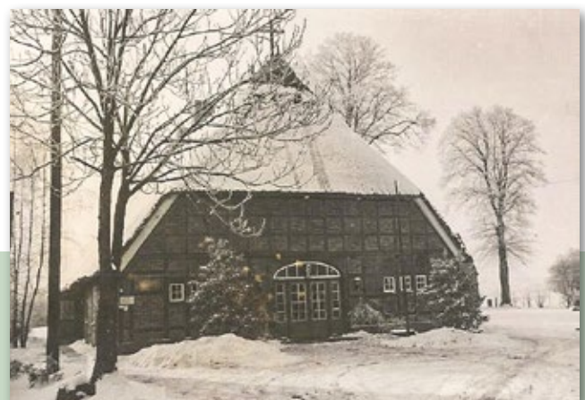
Haus Butenschön (Baujahr 1857). Der ehemalige Bauernhof hat in der Gegenwart als Kirche Verwendung gefunden. Er ist in Lage, Baukörper, äußerer Gestalt und baulichem Zustand erhaltenswert.
