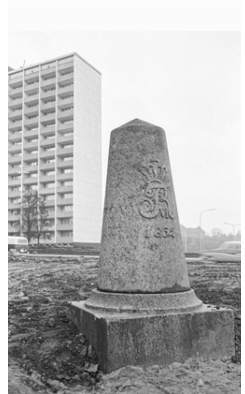
1967: Meilenstein an der Hamburger Chaussee an der Kreuzung Rendsburger Landstraße. Beim Bau des Waldwiesenkreisels musste der Stein umgesetzt werden.
