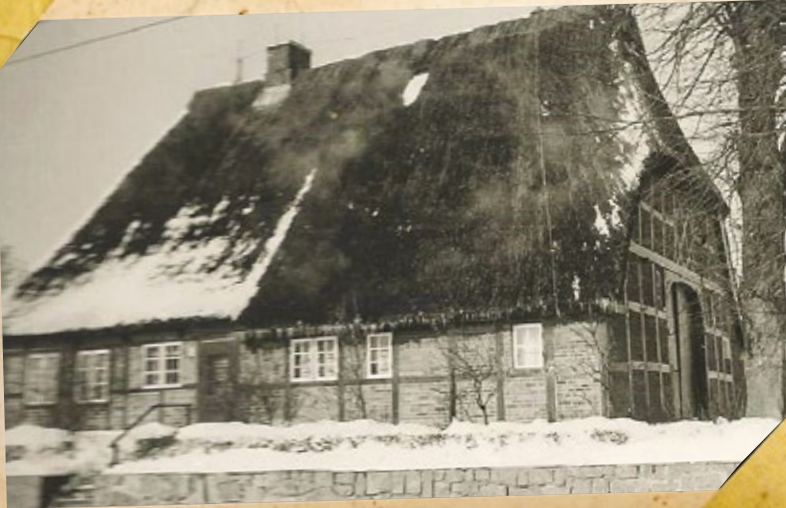
Der Hof von Anna Sell in der Dorfstraße 98 (Baujahr 1829). Hierzu schreibt Neupert: Das Bauwerk ist in Gestalt und Charakter besonders erhaltenswert. Es sollte zusammen mit dem kleinen selbstständig stehenden Stall als Gruppe bestehen bleiben.
