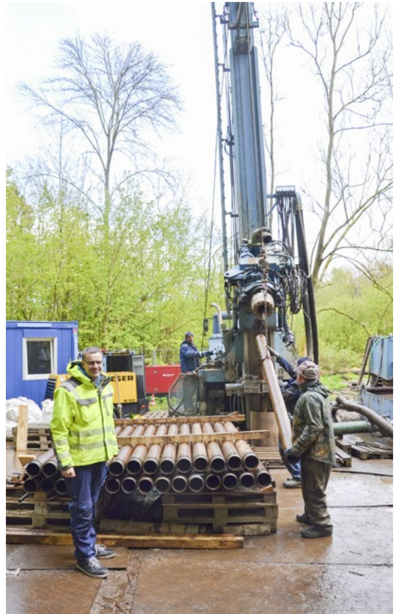
Erstmals seit 1972 lassen die Stadtwerke Kiel in Hammer für das Wasserwerk Schulensee neue Brunnen bohren, um alte zu ersetzen.
