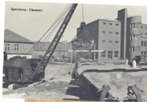
1943: Erdarbeiten für den Hochbunker in der Fröbelstraße. Im Hintergrund ist das Marinelazarett zu sehen.
