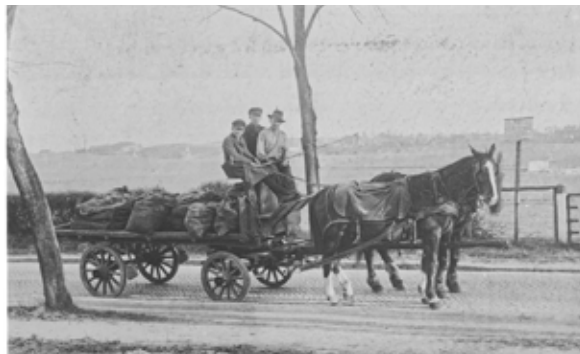
1928: Zur Befuerung der Schmiede wurde viel Kohle benötigt. Die Anlieferung erfolgte per Pferd und Wagen.
