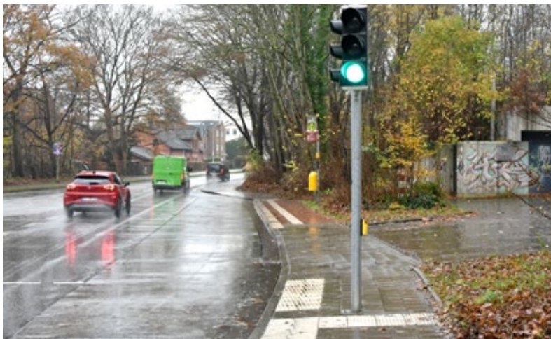
An der T-Kreuzung Hamburger Chaussee / Meimersdorfer Weg ist die Ampel unvorteilhaft mitten auf dem Gehweg platziert. Dieses soll vom Tiefbauamt geprüft werden.
