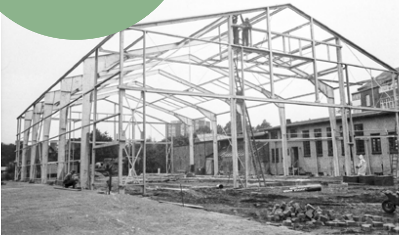
1976: Hinter dem Erweiterungsbau entsteht eine große Fahrzeughalle.
