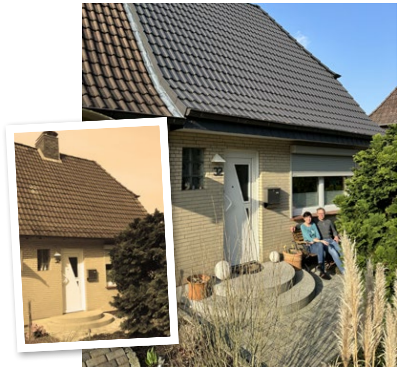
Die Doppelhaushälfte am Heckenrosenweg 32 vor und nach der Dachsanierung. Dabei hat das Krüppelwalmdach eine Aufsparrendämmung erhalten.
