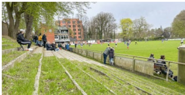
In den 1950er-Jahren fanden in diesem Stadion Spiele mit bis zu 15.000 Zuschauern statt. Heute sind die Ränge modernisierungsbedürftig.
