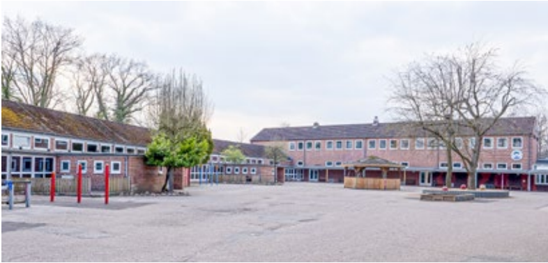
Die Schule am Eiderwald – die abgebildeten Gebäudeteile sollen nach aktuellen Plänen abgerissen werden. Fotos: Thomas Praefcke
