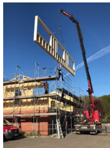
2018: Aufstockung zum neuen Bürogebäude
