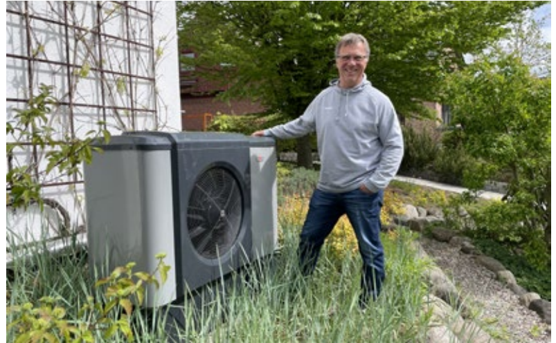
Christian Kaack neben der Wärmepumpe, die seit 2022 das Haus beheizt.
