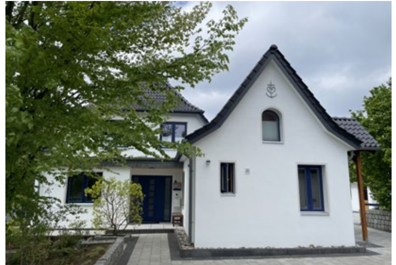
Das einstige Stallgebäude rechts von der Haustür wurde Schritt für Schritt mit einer Flächenheizung, einem neuen Dach sowie 16 cm Außendämmung ausgestattet.
