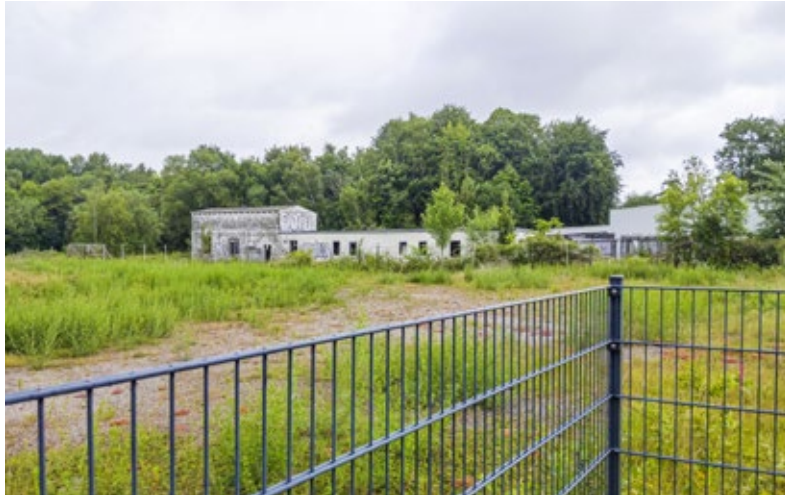
Wo im Gewerbegebiet Töpfergrube vor einigen Jahren die Sunkler-Krane waren, liegt eine große Mülldeponie im Untergrund. Die Pumpe zur Entgasung ist weit hörbar.
