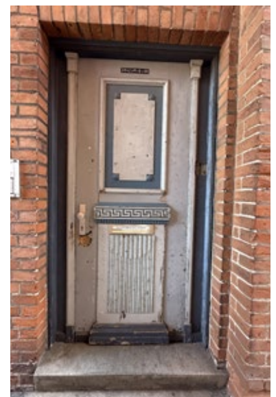
Die Eingangstür des Küsterhauses ist noch im Originalzustand erhalten. Sie wird denkmalgerecht saniert.
