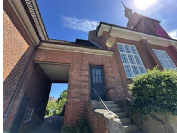
Die zweigeschossige Durchfahrt soll geschlossen und zum Eingang in das neue Gemeindezentrum umfunktioniert werden.
