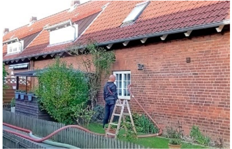
Bei dieser Kerndämmung wurde feinfaserige Glaswolle durch einen Schlauch in die Luftschicht des zweischaligen Mauerwerks geblasen.
