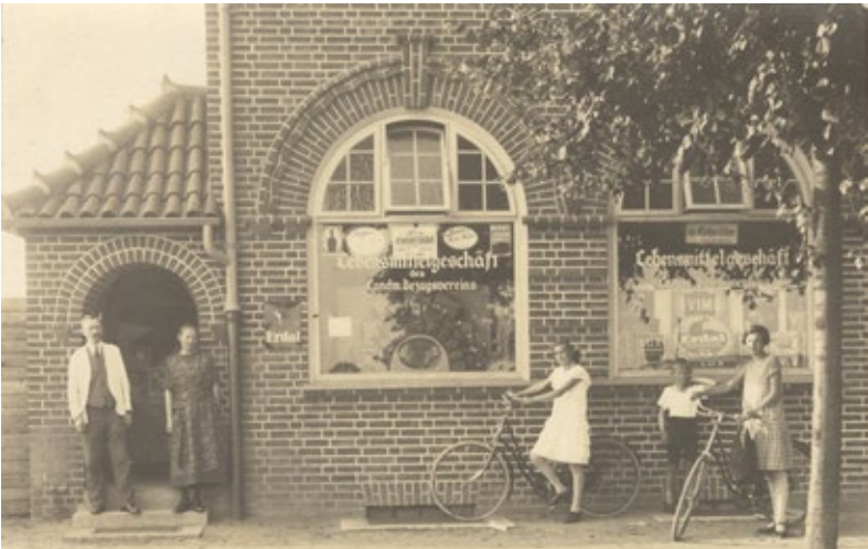
Die Sparkasse brachte das Wirtschaftsleben in Schwung. Vor 100 Jahren befand sich in dem ortsprägenden Gebäude mit Treppengiebel ein Lebensmittelgeschäft des Landwirtschaftlichen Bezugsvereins.
